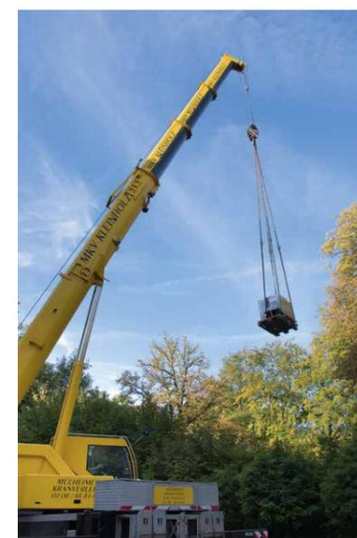
9 Tonnen wiegt der Linearbeschleuniger, der im Herbst 2018 mit einem Lastkran ins Gebäude der Strahlentherapie gehievt wurde.
