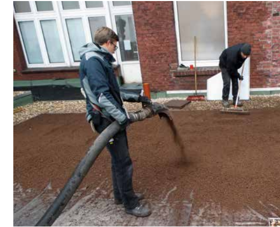
Links: Große Dachflächen im St. Josef-Hospital sind mit hohen Investitionen restauriert und wärmeisoliert worden.
